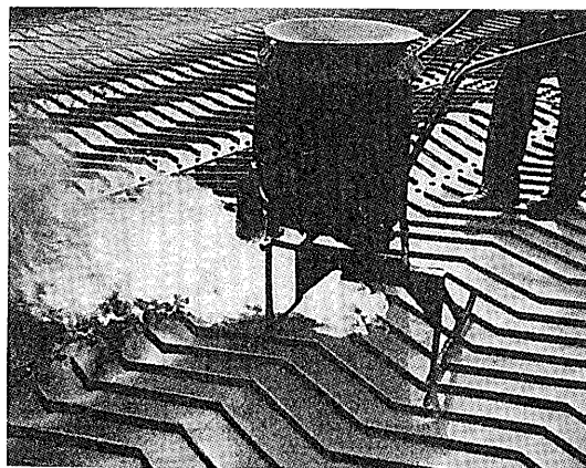
写真-1 デッキプレート上のジグザクプレート
