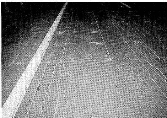
荒川第四橋（平成8年1月撮影）
