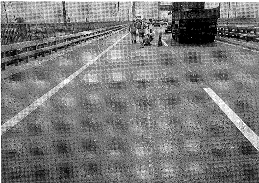
荒川第三橋（平成6年3月撮影）
