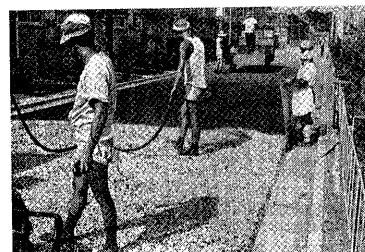
写真-1.2.5 失業事業による乳剤浸透式舗装風景
