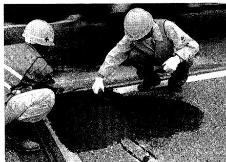
写真-1.2.13 スラリー状常温混合物の施工
