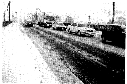
写真-2.4.6 ゴムロール舗装効果の例（手前）
