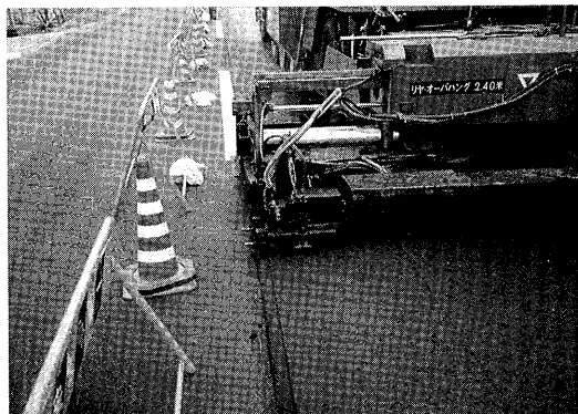
写真-2.4.3 無型枠施工装置
