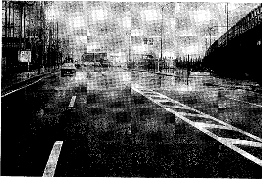
写真-2.4.5 排水性舗装（手前）
