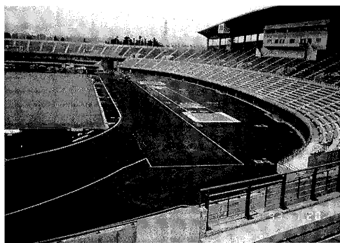
写真-3.7.2 陸上競技場走路の基層仕上り状況 (アスファルト舗装)
