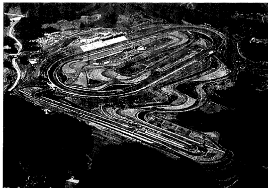
写真-3.8.5 建設中のツインリンクもてぎ (日本初のオーバルコースとレーシングコースを持つコース)
