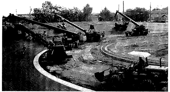
写真-3.8.1 専用機械による施工
