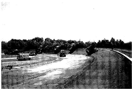
写真-3.8.4 高速周回路曲線部の急斜面舗装の施工
