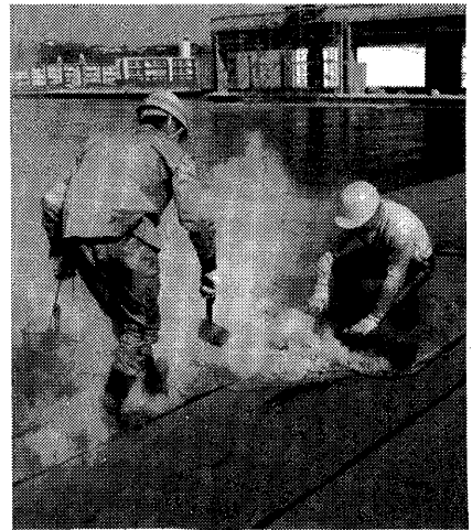
写真-4.1.9 アスファルト防水熱工法施工時の煙の発生状況 9)
