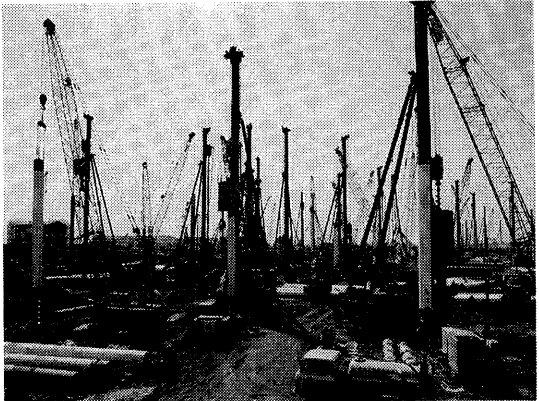
写真-4.2.2 施工現場写真（羽田空港拡張工事）
