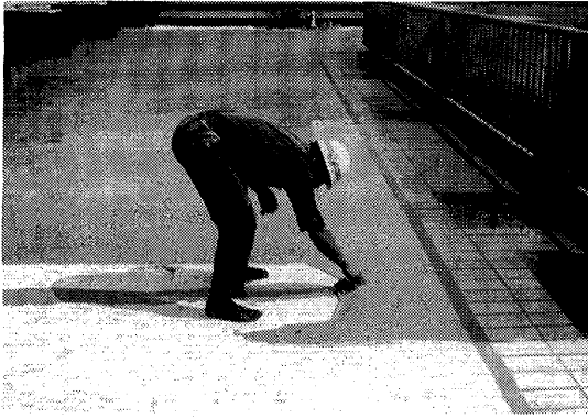
写真-4.1.5 塗膜防水工法の施工状況 5)
