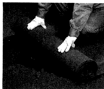
写真-4.1.12 クリーンタイプアスファルトでの施工状況 5)
