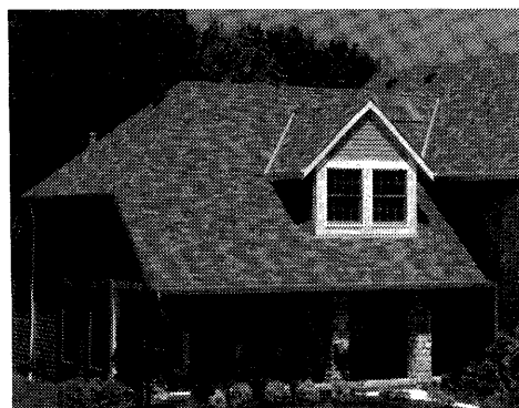
写真-4.1.14 米国でのアスファルトシングル葺き住宅
