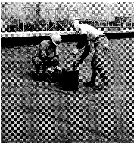
写真-4.1.2 アスファルト防水熱工法の施工状況 5)
