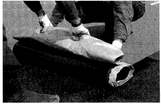
写真-4.1.6 自着工法の施工状況 5)
