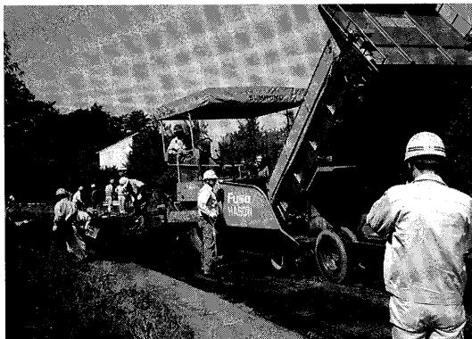
写真-1 常温型舗装の施工状況
