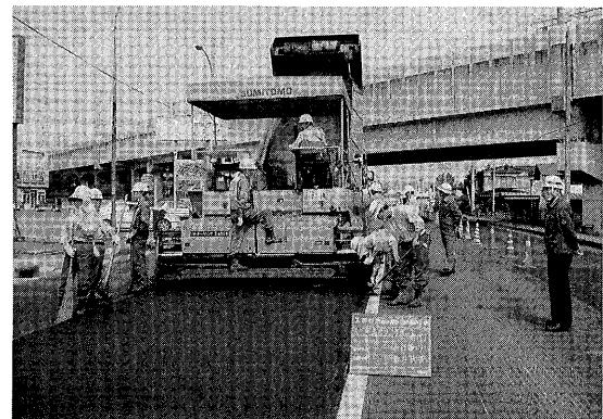
写真-3 常温型舗装D1の施工状況
