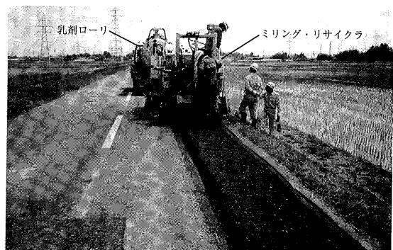
写真-1 Wirtgen 1000CRを用いた現位置常温表層再生舗装（宮城県河南町）
