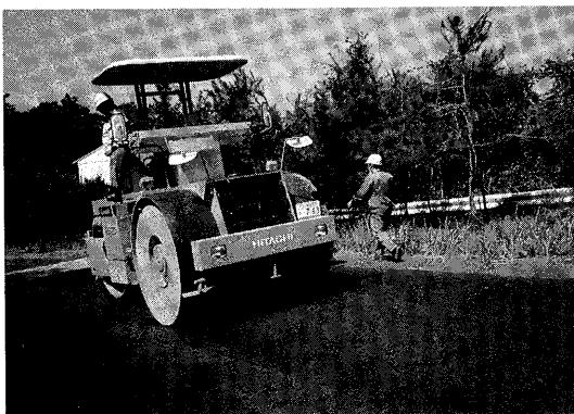
写真-2 常温型舗装の施工状況
