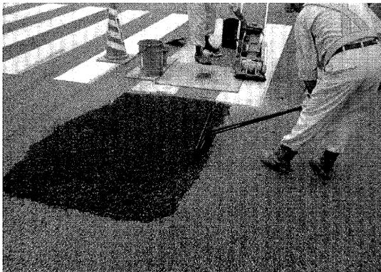
写真-3 常温排水性混合物による補修方法
