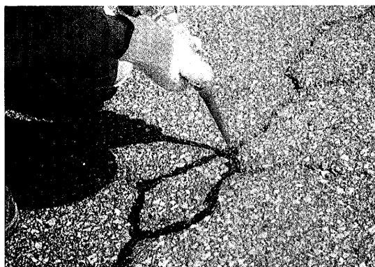
写真-2 常温注入型シール材の注入状況
