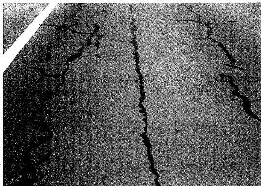
写真-1 加熱注入型シール材を注入した路面状況
