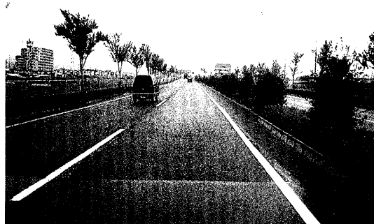
写真-1 調査箇所全景
