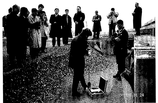
写真-18 路床の管理試験
