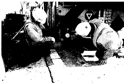
写真-4 平板載荷試験
