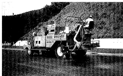
写真-1 散布機による散布状況
