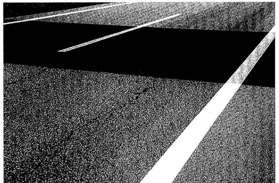
写真-5 真夏の日陰の部分でわだち割れが消えている状況
