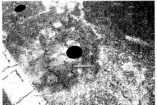
写真-2 わだち割れが網状に発達した舗装の表面。基層や安定処理層は健全であった。
