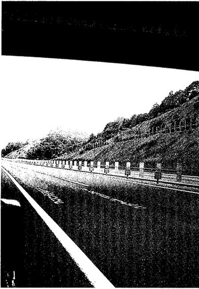
写真-6 真夏の日陰の部分にのみわだち割れがある
