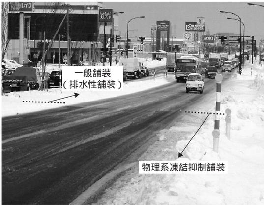
写真-1 凍結抑制効果による早期の路面露出
