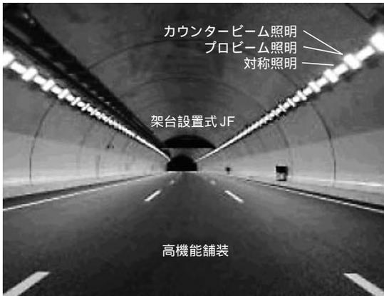
写真 - 2 斜め取り付け方式の例
