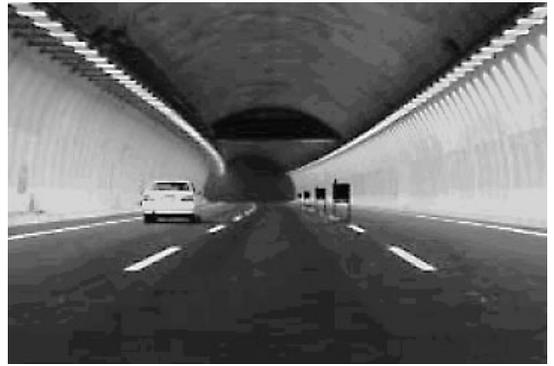
写真 - 4 側線上水平取り付けとしたプロビーム照明方式
