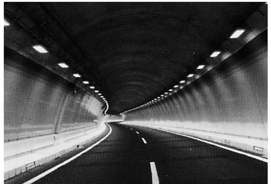
写真 - 6 直下型照明方式（青海トンネル）
