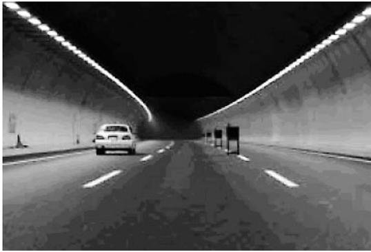
写真 - 3 側線上水平取り付けとした対象照明方式
