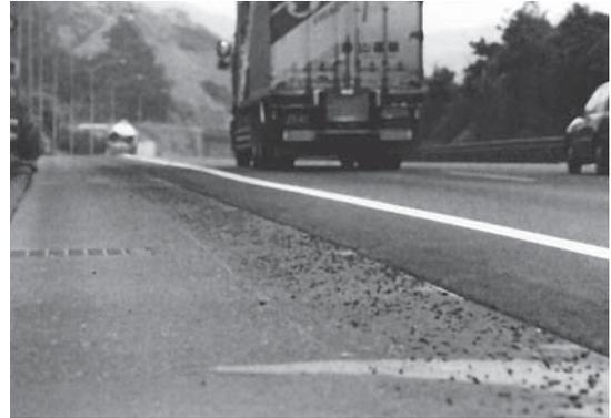
写真-3 路肩に骨材が散在している状況
