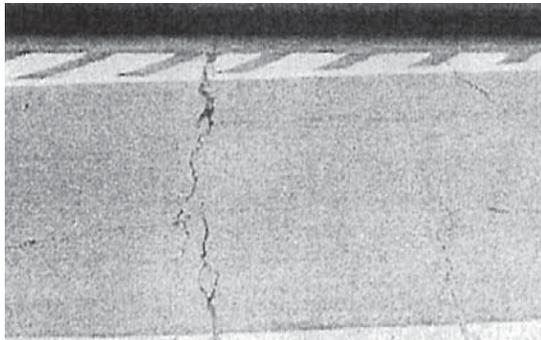
写真-2 ひび割れの例
