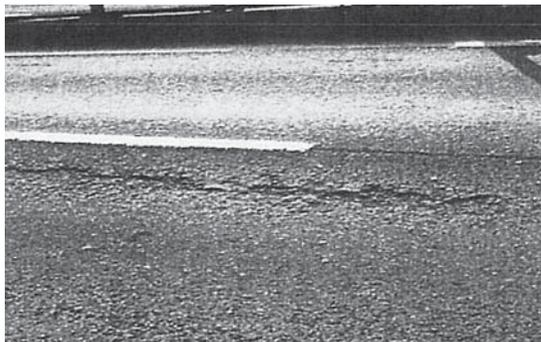
写真-1 わだち掘れの例
