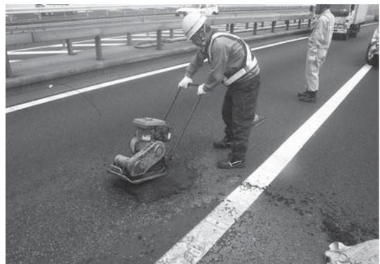
写真-4 穴埋め施工状況
