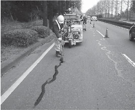
写真-1 シール材注入工法
