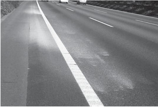
写真-1 砂分が噴出した状況（ポンピング現象）
