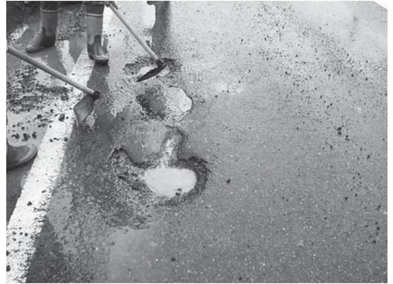
写真-2 降雨により発生したポットホール
