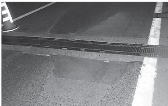
写真-5 段差修正工
