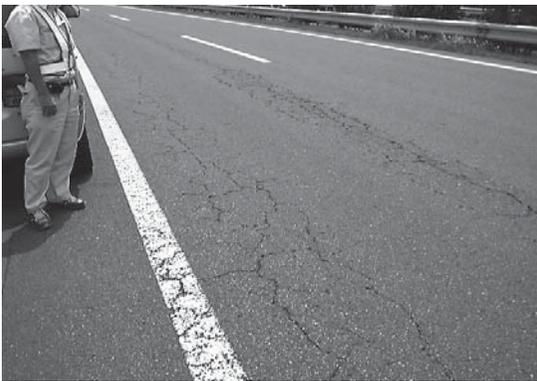
写真-2 密粒度舗装におけるひびわれ発生状況
