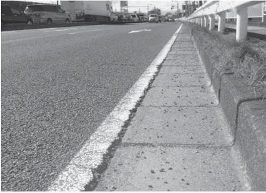
写真-2 骨材飛散の発生例
