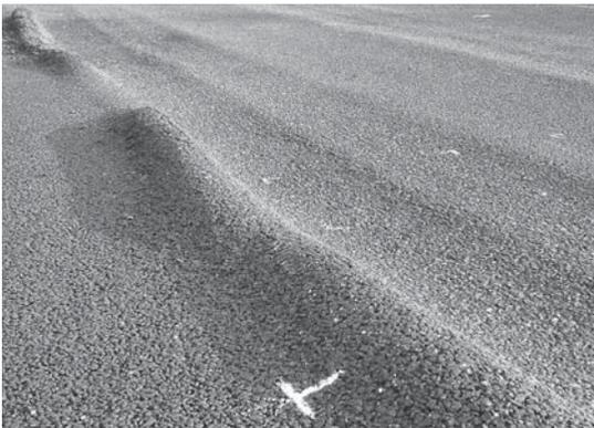
写真-4 局所的な側方流動の発生例
