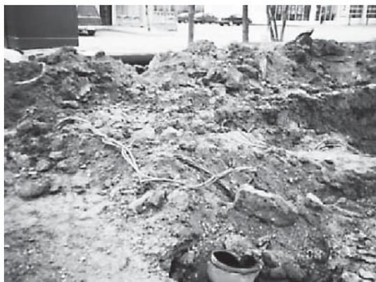
写真-3 路床掘削による土壌汚染
