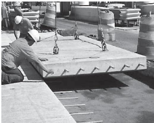
プレキャストコンクリート版を補修箇所に設置し、所定の位置にダウエルバーを埋め込む。
