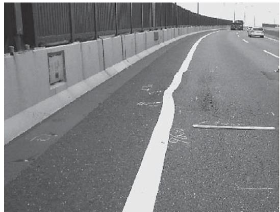
写真-1 局部的に発生した塑性変形
