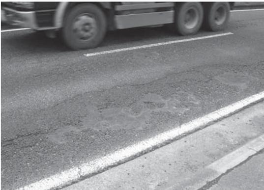
写真-3 ひび割れ+ポットホールの発生例
