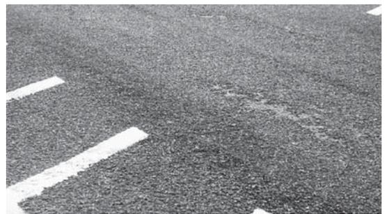
写真-1 骨材飛散が著しい箇所の路面状況
