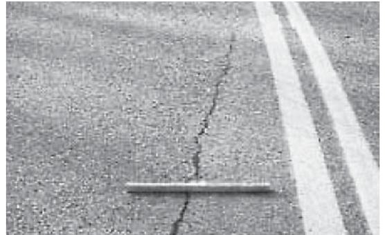
写真-7 「高」縦ひび割れの一例
