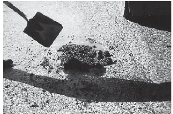
写真-36 材料の配置
