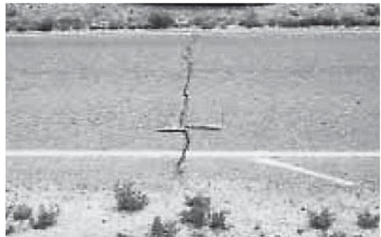
写真-10 「高」横断ひび割れの一例
