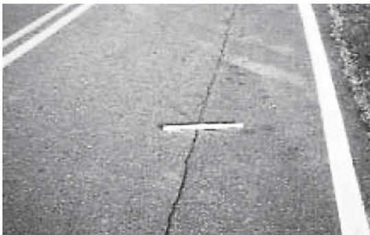
写真-6 「中」縦ひび割れの一例
