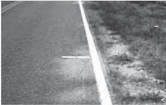
写真-5 「低」端部ひび割れの一例
