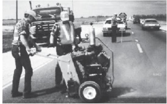
写真-32 ダイヤモンドブレードクラックスー
