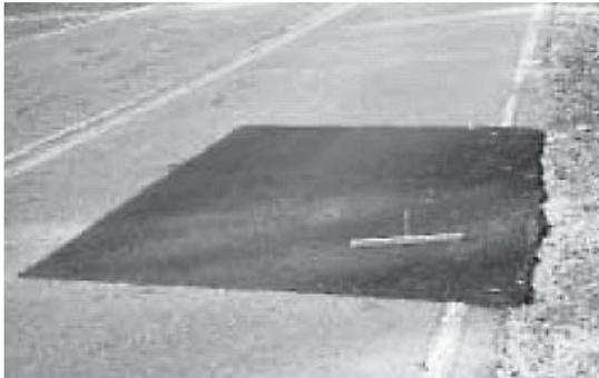
写真-11 「中」パッチング劣化の一例
