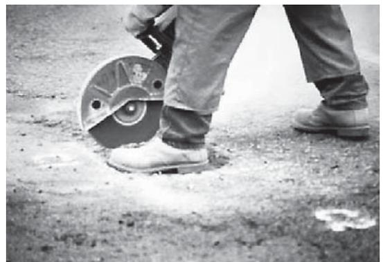
写真-38 舗装をカッターで側面処理
