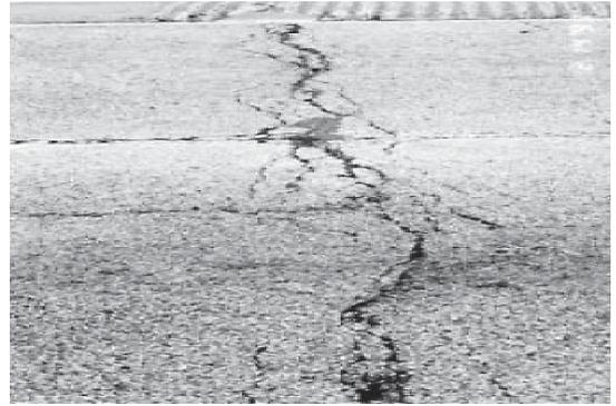
写真-28 ひび割れ修繕候補箇所
