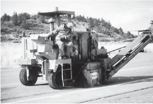
写真-39 コールドミルマシーンで側面処理
