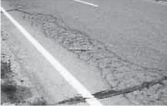
写真-2 「高」疲労ひび割れの一例
