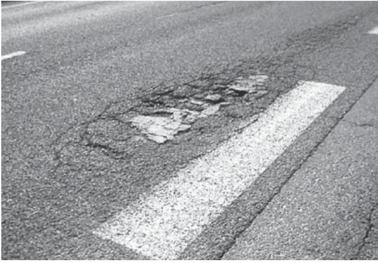
写真-2 路面の損傷状況
