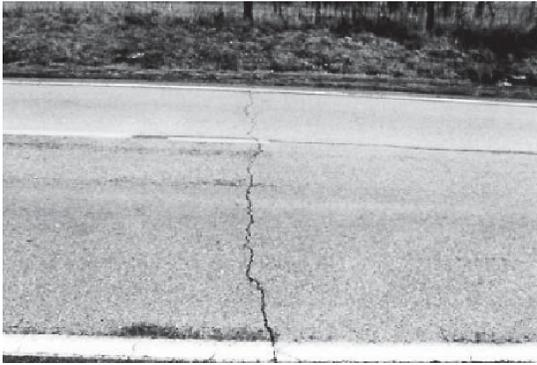
写真-27 横断ひび割れシーリング候補箇所
