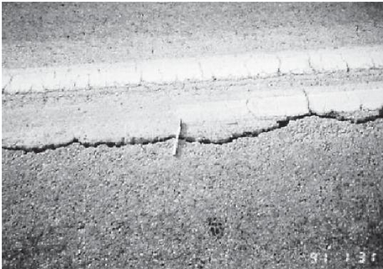
写真-29 縦断ひび割れ充填候補箇所
