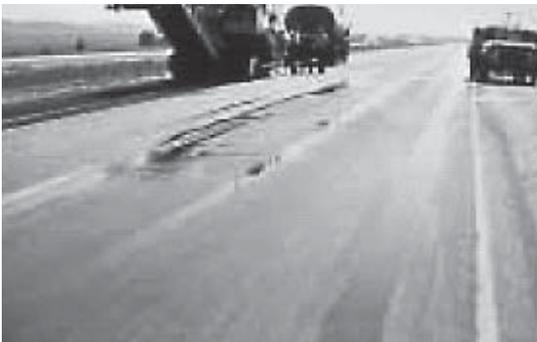
写真-16 わだち掘れに滞水している一例
