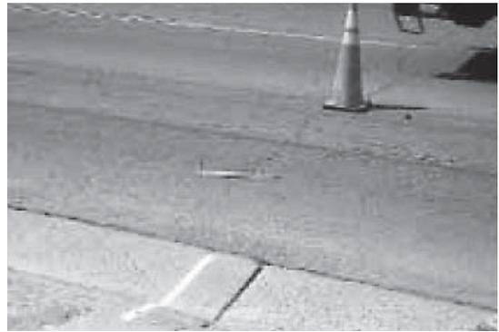
写真-9 「中」横断ひび割れの一例
