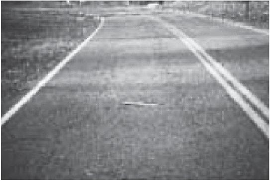
写真-3 「低」ブロックひび割れの一例
