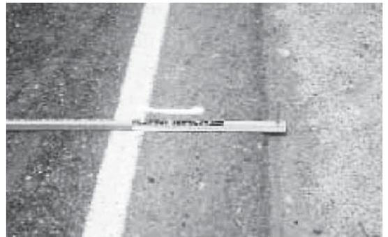
写真-23 路肩陥没の一例
