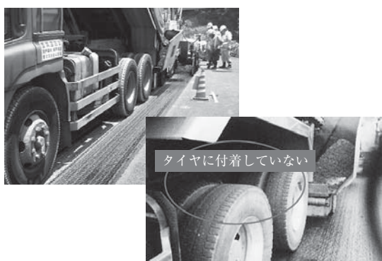
写真－1 タイヤ付着抑制型乳剤の施工状況
