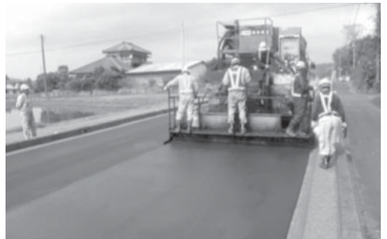
写真-5 マイクロサーフェシング工法の混合物敷きならし状況
