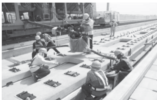
写真-8 新幹線スラブ軌道CAモルタル注入 (例)
