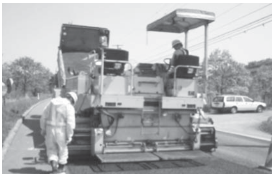
写真-3 乳剤・骨材同時散布機械を用いたチップシールの施工例
