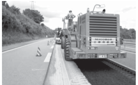
写真-4 路上再生セメント・アスファルト乳剤安定処理路盤工法の破碎混合作業状況
