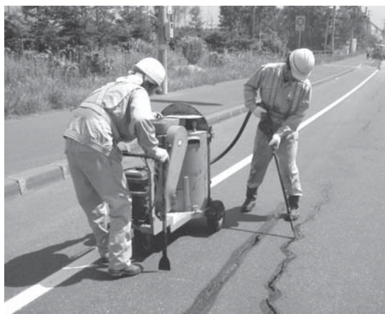
写真－5 ひび割れへのシール材注入状況
