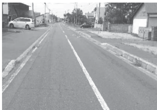
写真-2 測定区間 No.2
