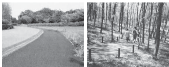
写真-7 木質系舗装 (例) 1)
