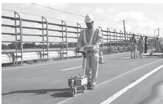
写真-4 交通規制内での測定状況
