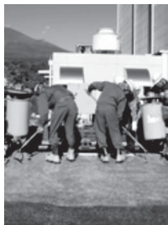
写真－6 PCM舗装の施工風景
