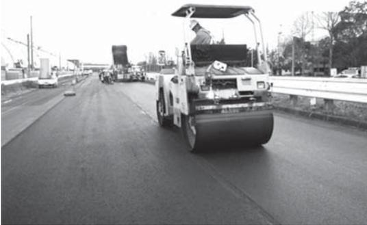
写真-1 試験舗装の施工状況
