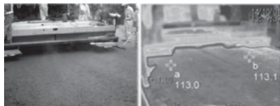
図-7 施工状況および路面温度
