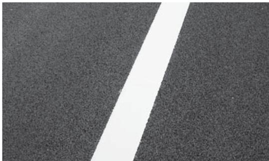
写真-1 第3世代PAの施工後舗装面
