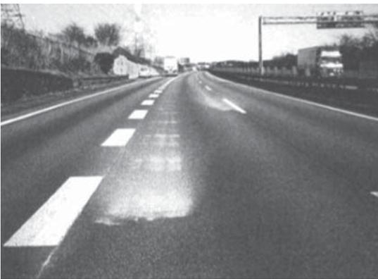
写真-1 基層の剥離に伴う不具合（ポンピング）
