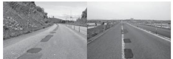
写真-1 排水性舗装の破損状況
