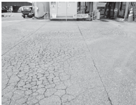
写真－1 工場内の施工前の路面の状況
