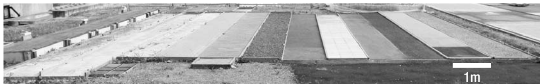
写真-13 試験施工ヤードの歩行者系舗装
