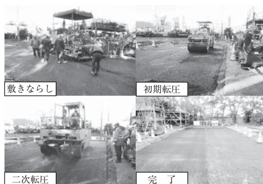
写真－3 施工状況
