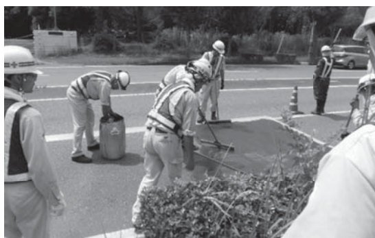
写真-5 敷きならし状況 (タイプB)
