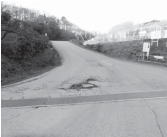
写真-3 工場内の構内道路の施工前の状況
