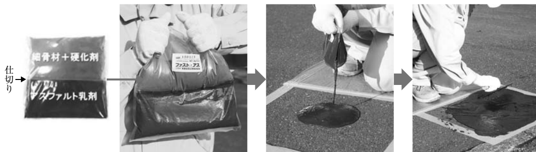
写真-3 ファスト・アスの施工方法
