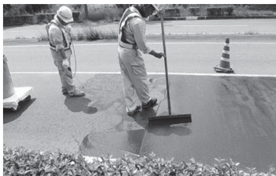
写真-7 敷きならし状況 (タイプC)
