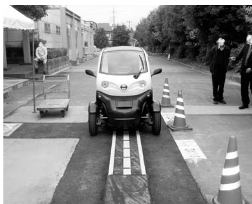
写真－６ 走行中給電舗装の受給電実験
