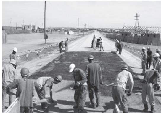
写真-3 バインダと骨材散布
