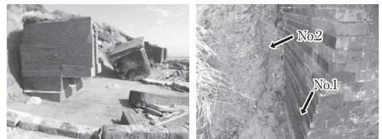
写真-3 第二砲台付近煉瓦構造物と防水材 (No.1, 2)
