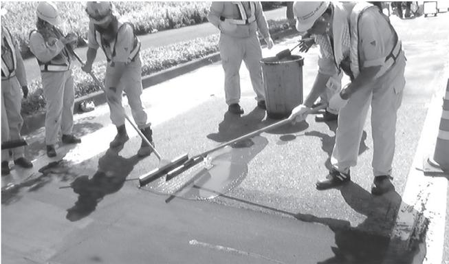
写真-1 薄層表面処理の施工状況 (薄層表面処理A)
