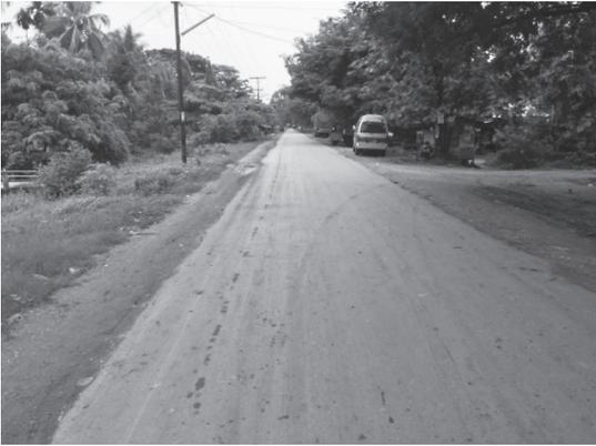
写真-20 一年経過後の試験舗装現場
