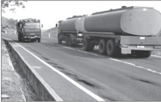
写真-1 急勾配（7～9%）、高温区間の流動わだち掘れ（エチオピア）
