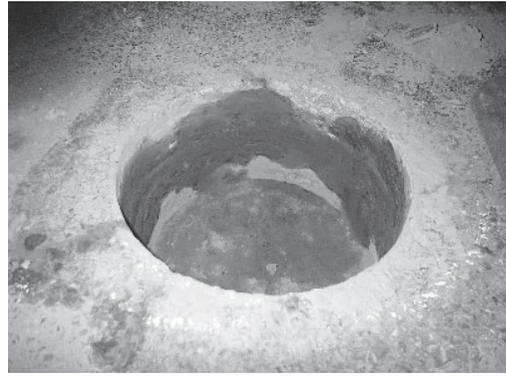
図-6 コア採取孔における水の染み出し(区間J)(左:コア採取直後,右:コア採取30分後)
