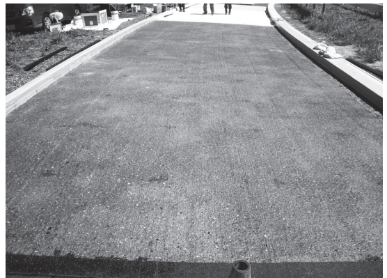
写真-6 浸透防水材塗布完了
