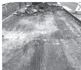
写真－5 舗装剥取り後の 床版
