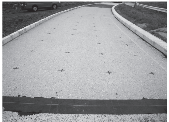
写真-5 切削・表面処理完了
