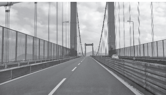
写真-16 路面の状況
