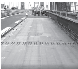
写真－6 表面処理後の 床版
