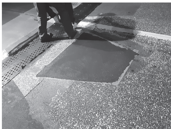
写真-2 段差修正材の施工状況
