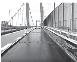
写真－8 接着剤塗布後の 床版
