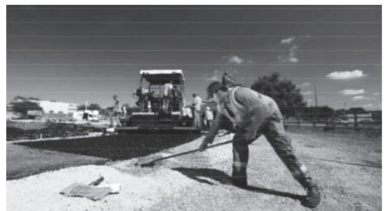
写真-3 再生骨材を用いたバイオベース層の施工
