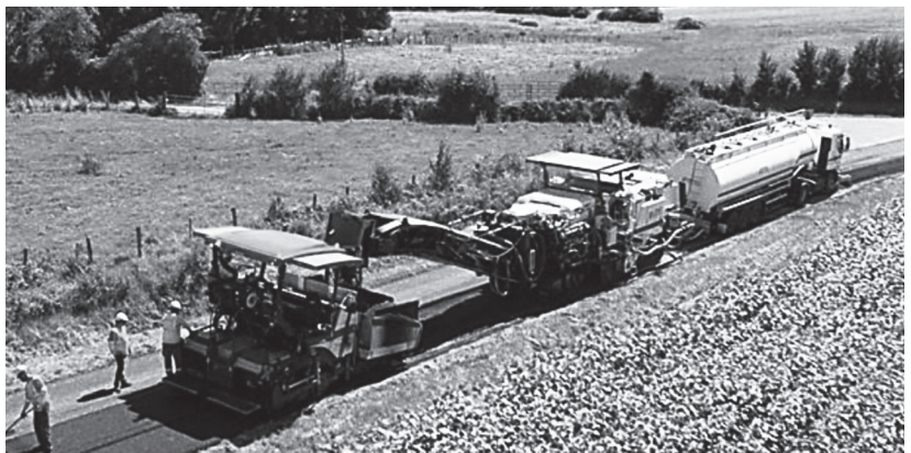
写真－2 Recytal® を用いた路上表層再生の例（右端のローリーから乳剤を散布）
