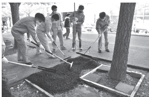
写真-7 アスファルト実習の様子
