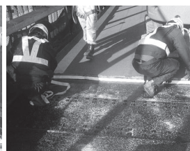
写真－12 舗装切断部 防水処理
