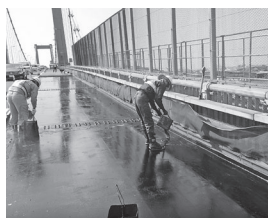
写真－9 防水材塗布
