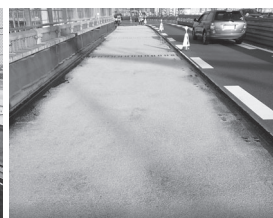
写真－10 防水材塗布後の 床版
