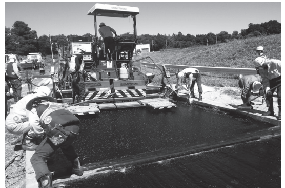
写真-7 改質グース施工状況
