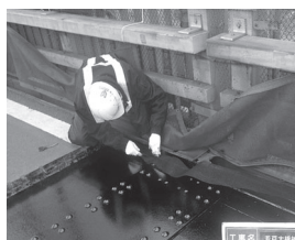
写真－11 路肩防水処理
