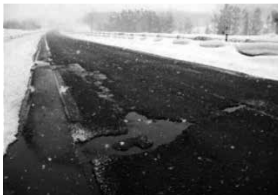
写真－4 高機能舗装Ⅰ型の損傷状況 13)
