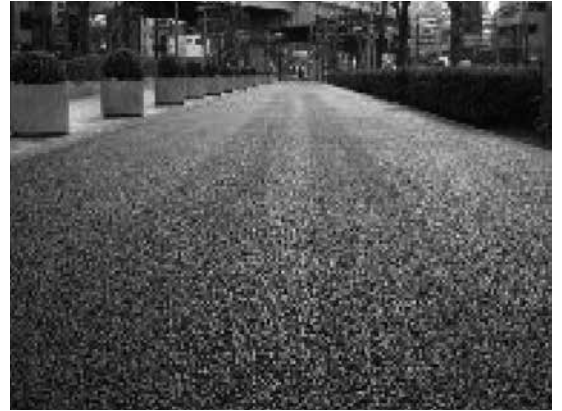
写真-5 開粒度アスファルト混合物 5)
