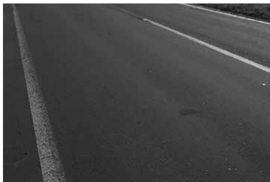
写真-2 摩耗わだちの損傷事例
