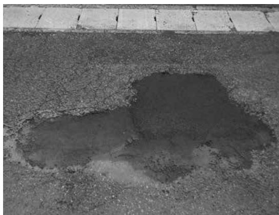
写真-1 パッチング工法による維持事例
