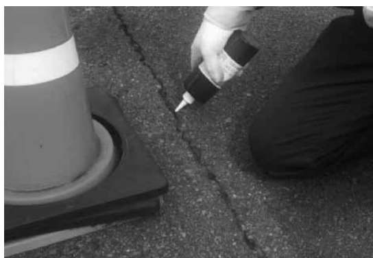
写真-2 シール材注入状況
