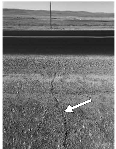
写真-5 路盤に発生したひび割れの例
