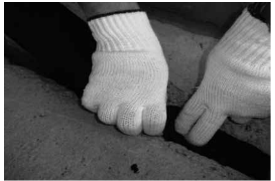
写真-9 二次止水材の設置状況
