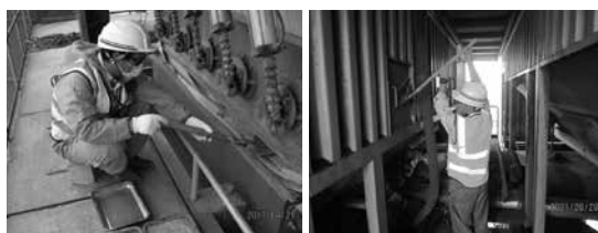
写真-2 対象国にある外国製APでの ホットビン試料採取
