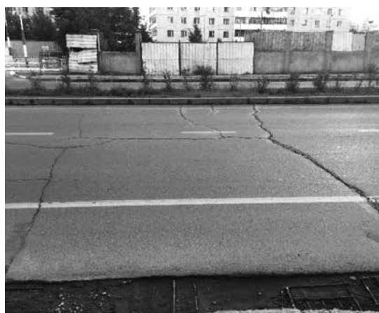
写真-1 モンゴル国内の低温ひび割れの例
