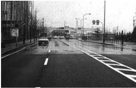
写真-9 排水性舗装の適用事例 19)
