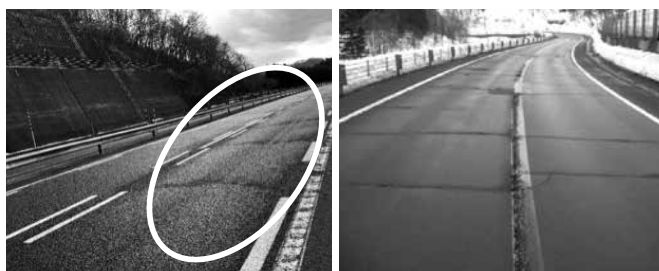
写真－1 低温ひび割れ（左：高速道路上、右：一般道路上 11) ）
