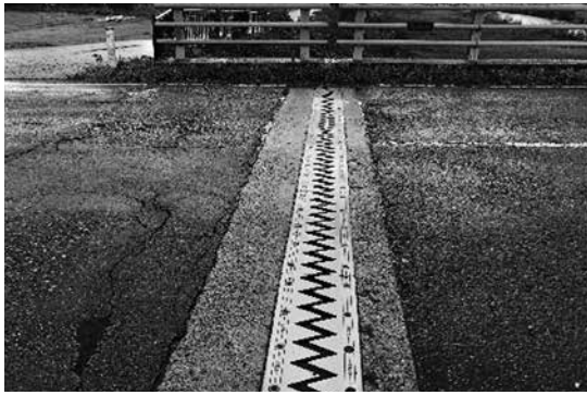
写真-1 荷重支持型のジョイント
