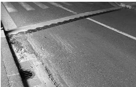
写真-5 施工前の破損状況
