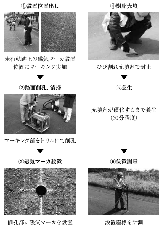
図-8 埋設型磁気マーカのマニュアル施工
