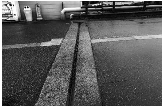
写真-2 突合せ型のジョイント
