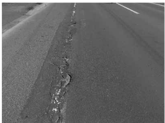
写真-3 ポットホールの損傷事例
