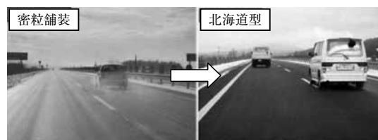
写真－5 スモーキング状況 （同一日に同一IC間で撮影） 14)
