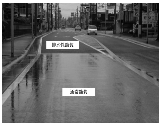
写真-6 排水性舗装の効果 8)
