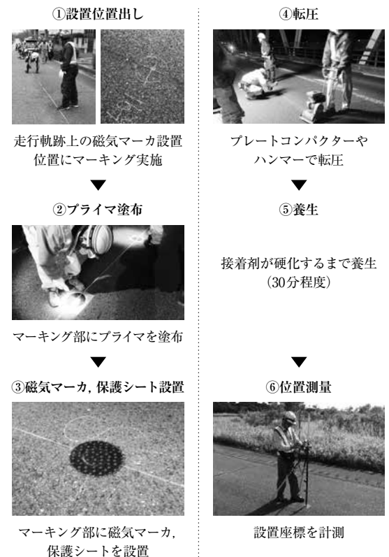
図-9 貼付型磁気マーカのマニュアル施工
