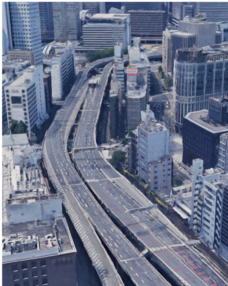
【上空から見た日本橋周辺の首都高[現状]】
