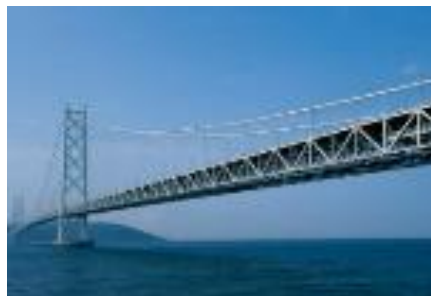
明石海峡大橋
