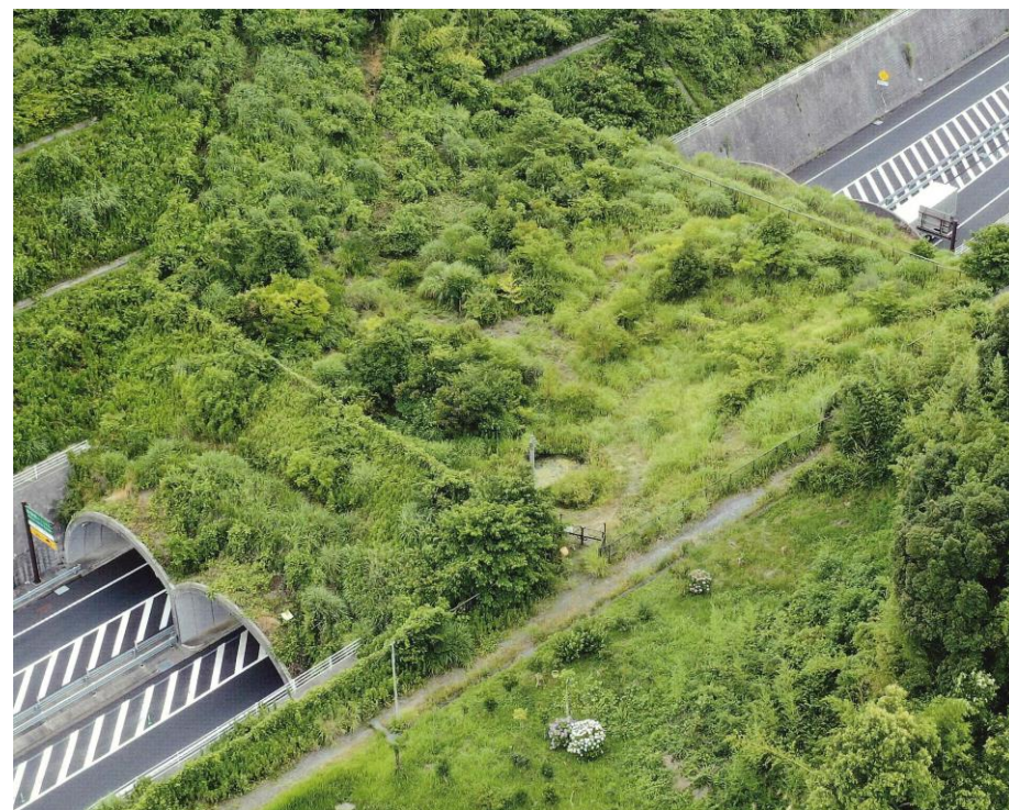
もばら動物の橋 圏央道
