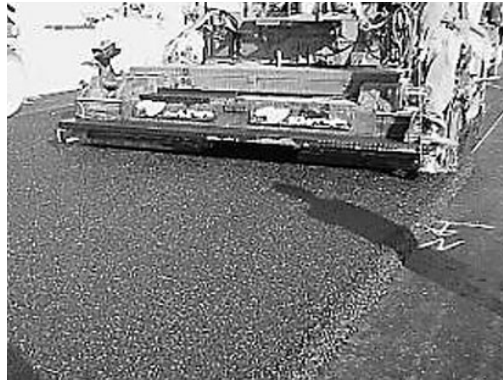
図 - 7 ダブルタンパ式フィニッシャーによる敷均し
