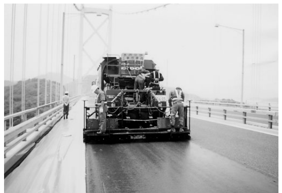
写真 - 1 敷きならし状況（橋面舗装上）
