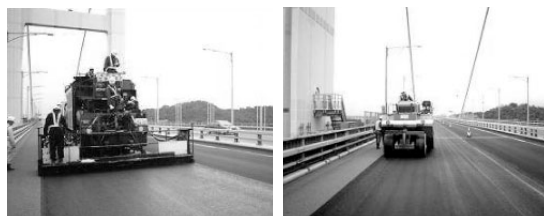
敷き均し タイヤローラによる転圧 写真-1 MS施工状況
