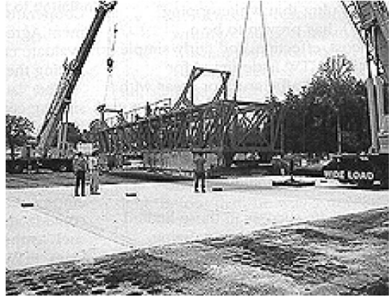
写真 - 26 クレーンにより搬入されるALF
